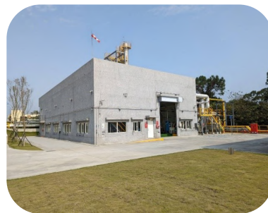
林口燃氣鍋爐廠房外觀
