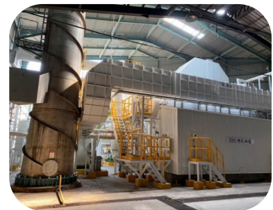
樹林燃氣鍋爐廠房外觀
