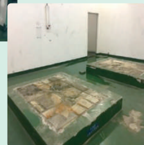
NF 3 罐裝區管線設備拆除
