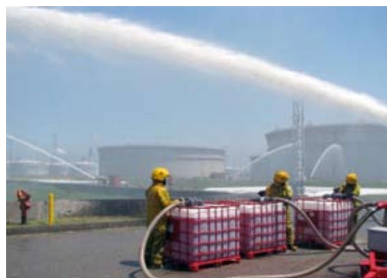
台塑石化公司大型儲槽洩漏應變演練，模擬強烈地震導致13萬噸油槽破裂引燃造成重大火災。廠區消防隊立即佈署10,000GPM大流量砲塔及12英吋水帶車進行水線佈置連結，出水保護鄰近油槽，避免火勢波及蔓延。
