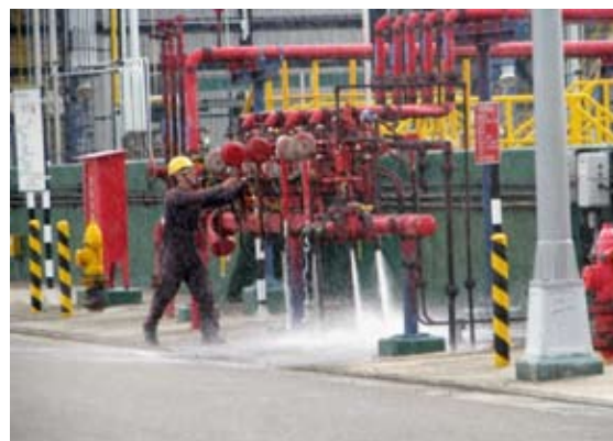
台化公司ARO-3廠苯儲槽管線洩漏應變演練。應變人員將儲槽及周邊貯槽一齊開放閥打開灑水降溫保護設備。緊急應變小組搶救班著A級防護衣，在消防水霧壓制下，進入災區針對洩漏源進行止漏作業。
