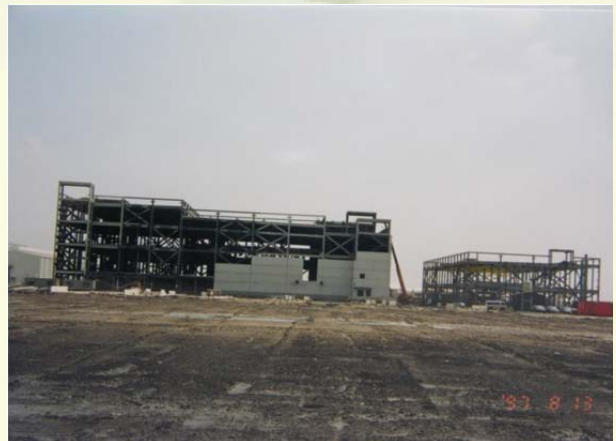
8 吋廠鋼構、外牆建設
