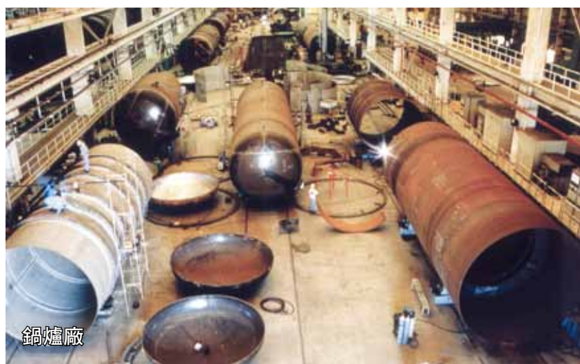
機械廠塔槽安裝
