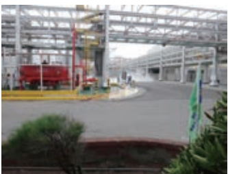
地震造成丙烯腈管線洩漏 巡檢人員曝露環境感到身體不適
