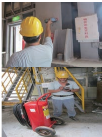
圖 6 以 PDA 進行到位點確認並輸入設備檢查結果
